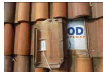
Foto 2 - Posa delle sonde di temperatura sulla copertura con alluminio
