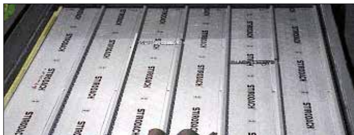
Prova di resistenza al carico discendente - Rel. Tecnica nr. 4367/RT/07 Vista estradosso del campione prima della posa delle tegole
