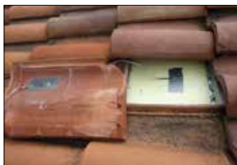
Foto 1 - Posa delle sonde di temperatura sulla copertura senza alluminio
