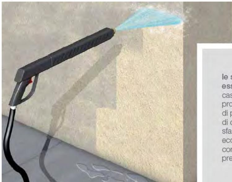
le superfici devono essere pulite ed in caso contrario si dovrà procedere alla rimozione di polvere, sporco, tracce di disarmante, parti sfarinanti ed incoerenti, ecc. mediante lavaggio con acqua pulita a bassa pressione (max 200 bar)
