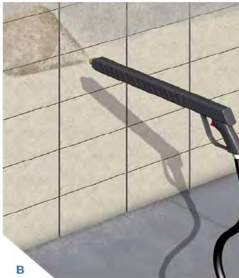
**Nel caso di rivestimenti ceramici** si procederà con una accurata mappatura per valutare l'eventuale presenza di distacchi che andranno eliminati. **(A)** Andrà inoltre valutato il caso di procedere con una idrosabbatura a seconda della presenza o meno di superfici smaltate o vetrose con la finalità di rompere la vetrina ed avere una migliore superficie di aggrappo per il collante. **(B)**
